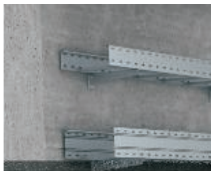
Монтаж към стената Директен стенов монтаж на кабелната скара
