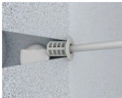
Вкарване на инжекционен хоросан След почистване на отвора да се фиксира центращата втулка. След това се изсипва сместа от флакона в посока от дъното на отвора навън.
