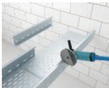
Изграждане на Т-образно отклонение с монтажнен ъглов елемент Прорязване на борда на едрогабаритната скара.
