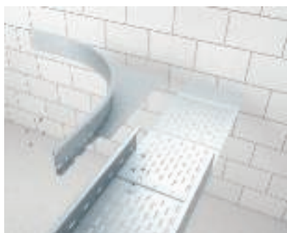
Изграждане на Т-образно отклонение с монтажнен ъглов елемент Монтаж на първия монтажнен ъглов елемент тип WEAS 110.
