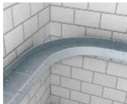
Монтаж на ъгъл 90° Ъгъл за едрогабаритни кабелни скари. Ъгълът се монтира посредством външни съединители и дънна планка за челни снадки.
