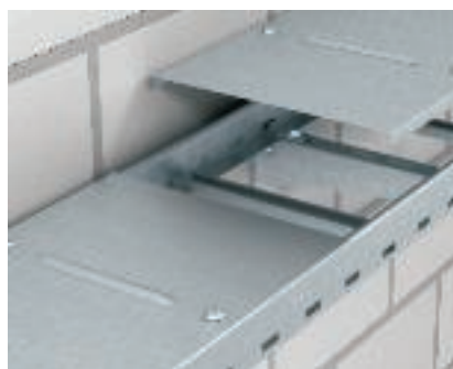
Монтаж на капака Поставяне и закрепване на капаците посредством въртящо се ключе тип DRL върху кабелната стълба.
