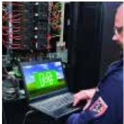
Намалете общите разходи за притежание и удължете експлоатационния живот на оборудването с правилния вид обслужване.
