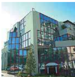
Управление на отоплението и вентилацията в сгради
