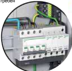
Катоден отводител iPRD 4P + IC60N 4P
